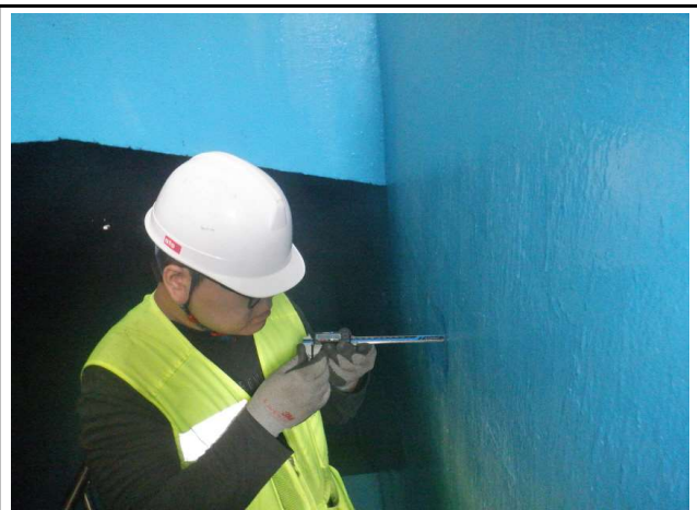
탄산화 깊이 측정
