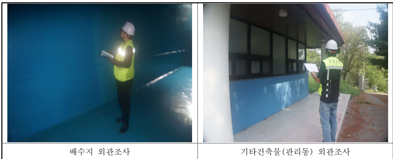
【사진 3.1】 시설물 외관조사
